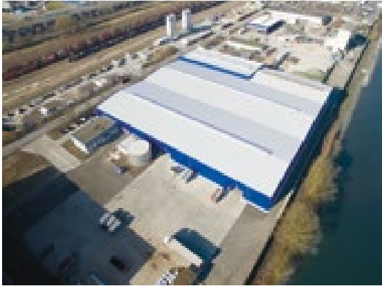
Standort der neuen PET-Aufbereitungsanlage ist ein verkehrsgünstig gelegenes Areal am Hamburger Hafen
