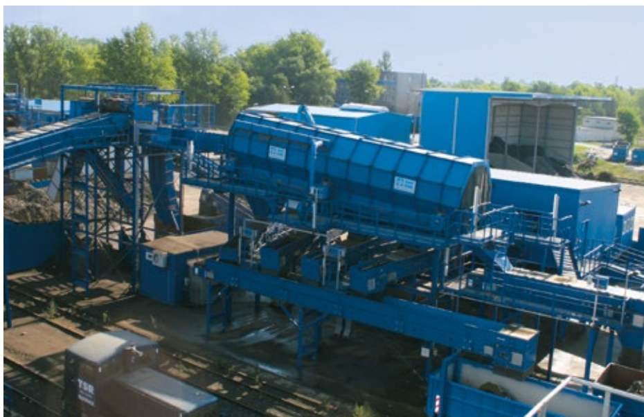
Stąła kontrola i optymalizacja instalacji stanowi część inicjatywy obniżania zużycia energii
