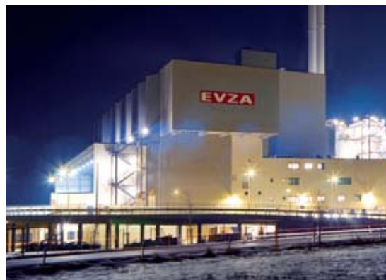
EVZA w Staßfurt to jeden z najnowocześniejszych zakładów w Niemczech.
