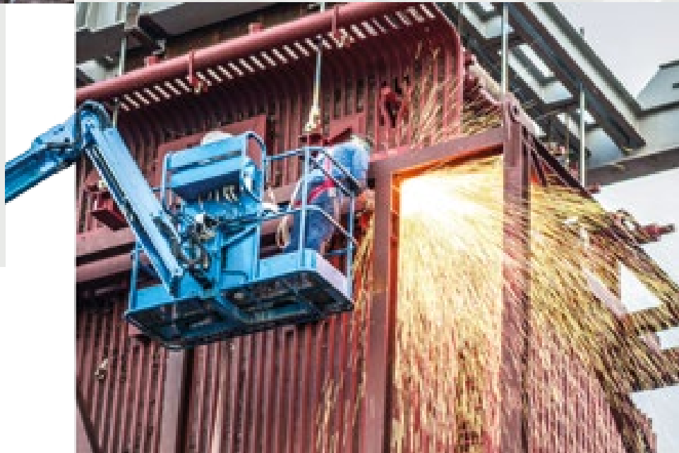
Wyjęcie nowego kotła z konstrukcji transportowej
