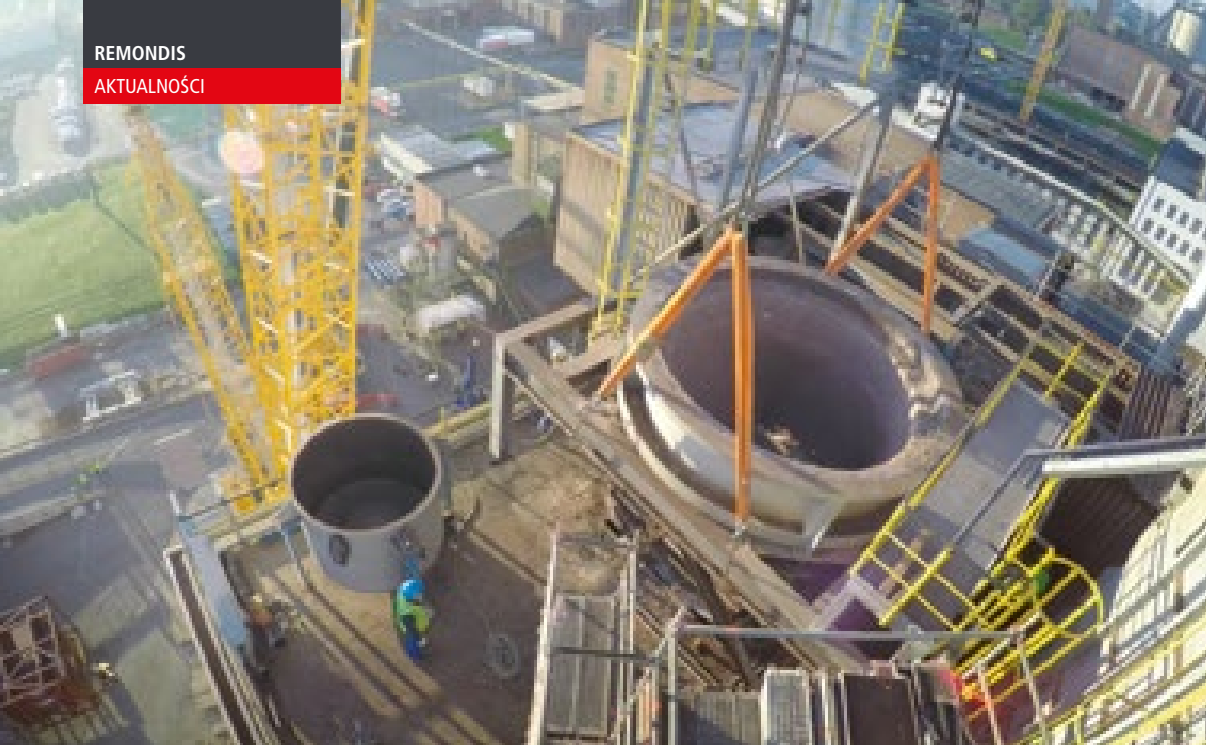
Demontaż starego kolana spalinowego
