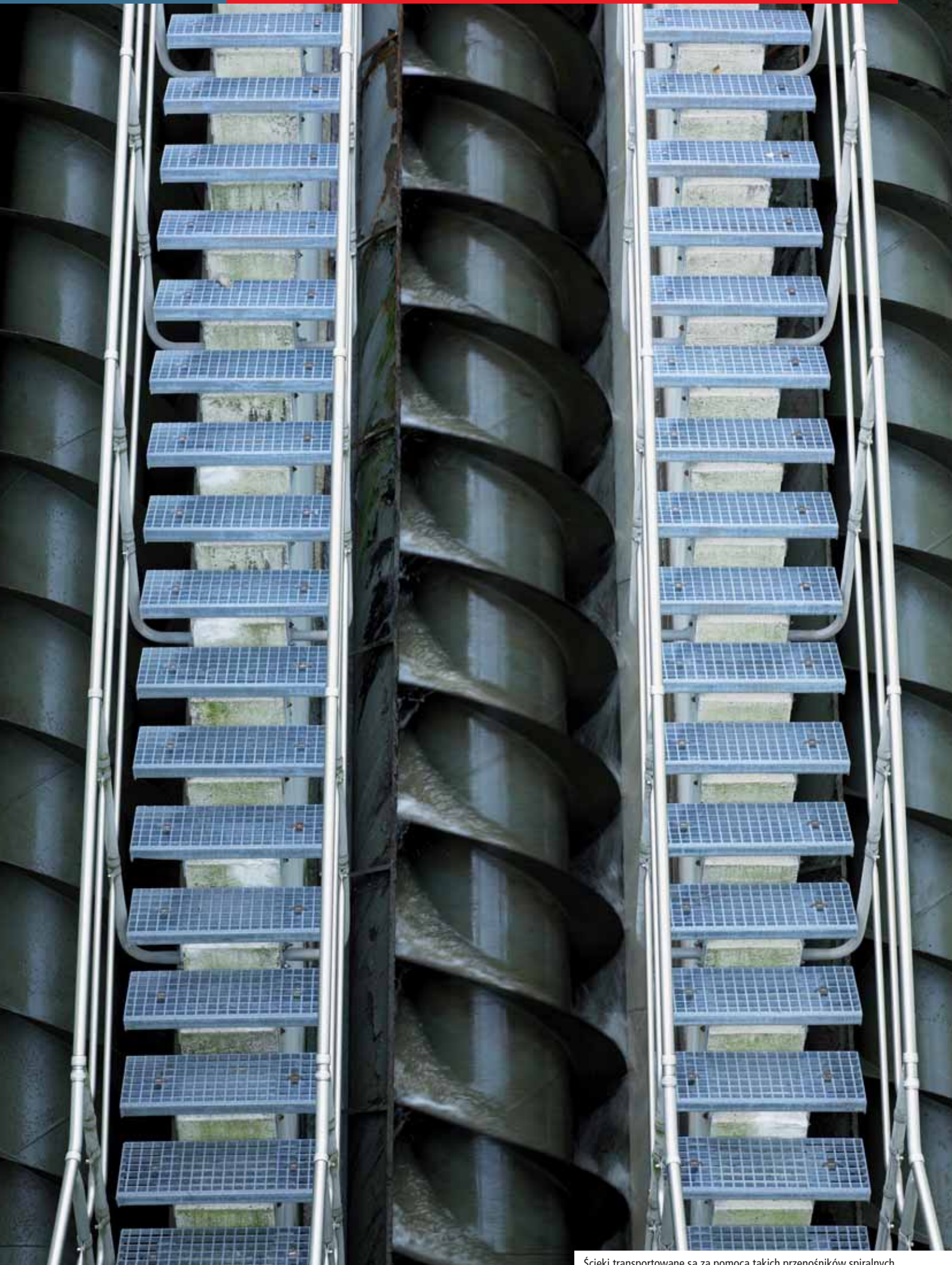
Ścieki transportowane są za pomocą takich przenośników spiralnych
