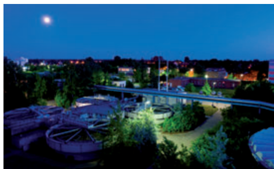
Oczyszczalnia, zakład wodociągów
