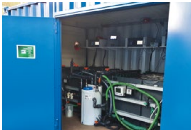
Rzut oka na technikę – kontener instalacji pilotażowej, w którym jest umieszczone ogniwo paliwowe
